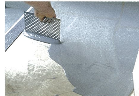
... mit Spachtel und Rakel gleichmäßig ausbringen ...
