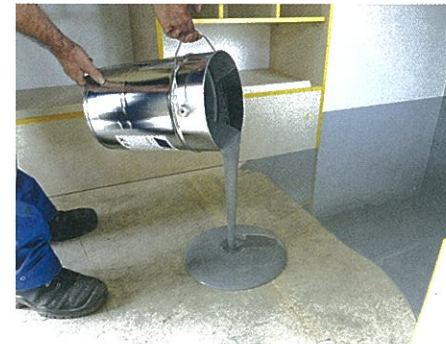
Boden versiegeln á la RKB: Beschichtung (hier Sabacoat) ausgießen ...
